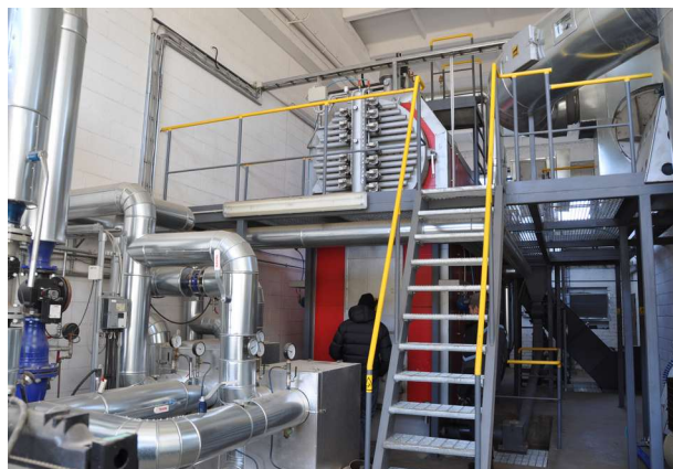
Fotod 5. Vinni Katlamaja (vasakul Biogaas koostootmiskonteiner): Askoterm gaasikatlad ja pumbatorustik ning Metsahake hakkepuiduladu ja katel
