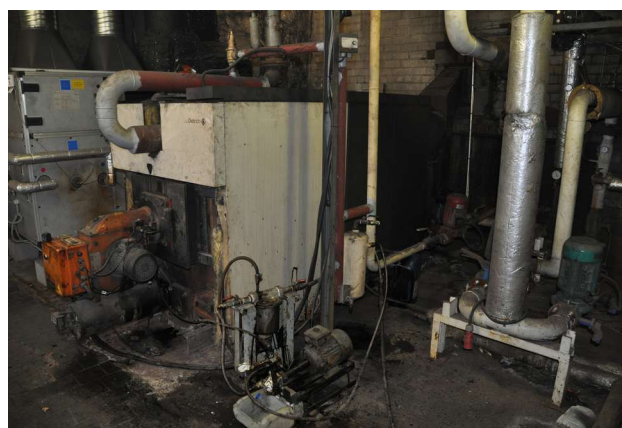
Fotod 8. Laekvere Katlamaja end. Vallamaja tiivas (pildil paremal) amortiseerunud õlikatlag
