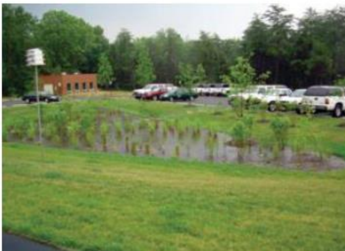
Joonis 3.22. Biopuhver (allikas: Infragate Eesti AS, 2016).
